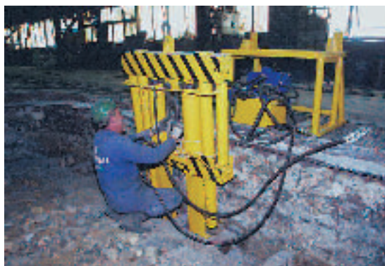
Realización del trabajo utilizando la máquina extractora hidráulica.
