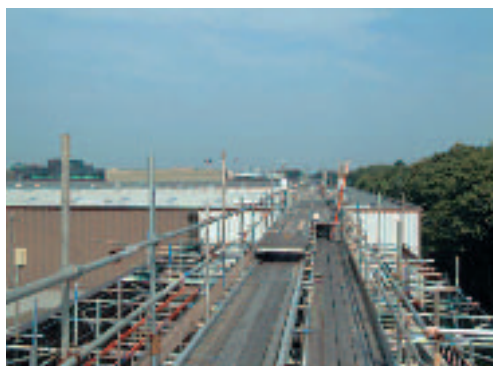
Andamio para la carga de materiales y sistema de carretilla en la cubierta.
