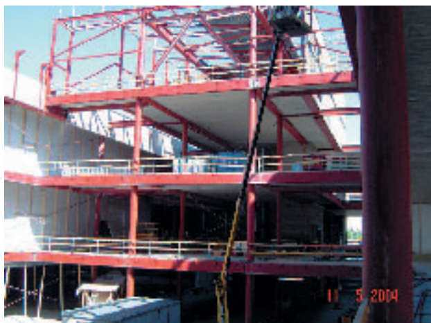
La obra de construcción en continuo cambio.
