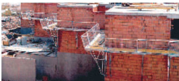
Utilización de andamios.
