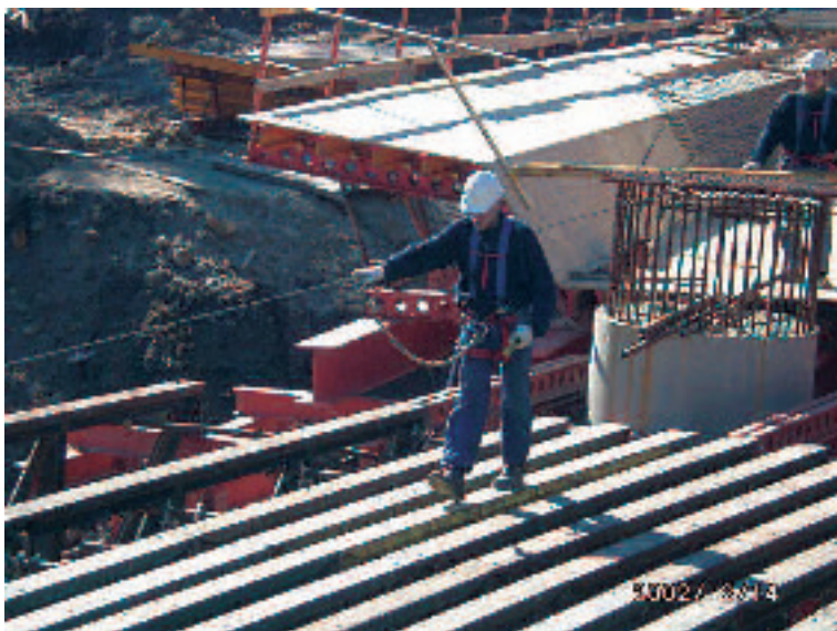
Utilización de un equipo de protección contra caídas antes de instalar el sistema de barandilla.
