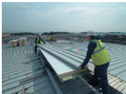
Instalación de las chapas de la nueva cubierta.
