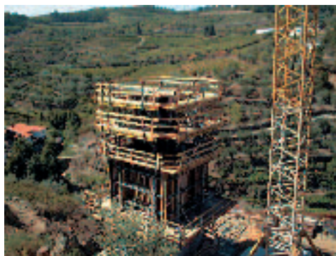
Puente en construcción.
