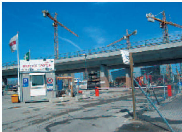
Entrada a la obra.
